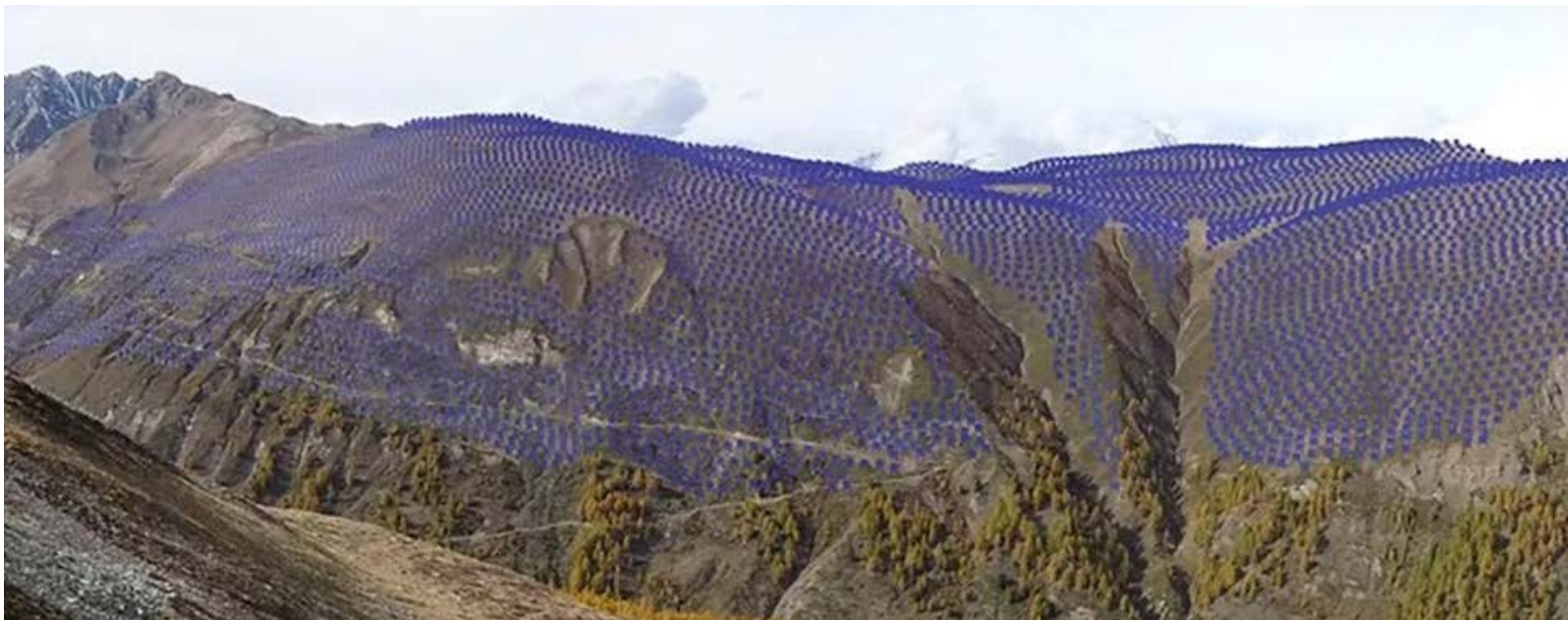
Modellbild der geplanten PV-Anlage Saflischtal-Grengiols mit 1500 MWp Leistung auf rund 2400 Metern über Meer. Bild: Projekt Saflischtal-Grengiols / CCN Häring.
